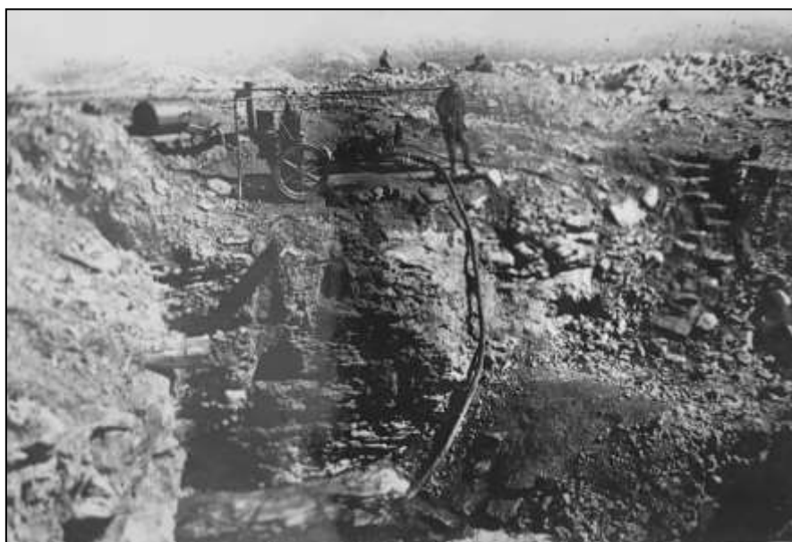
Рис. 18. Насосная станция в карьере Алиберовской шахты. (Фото из отчета о геологоразведочных работах в 1950 г. (Глазов, 1951)).
