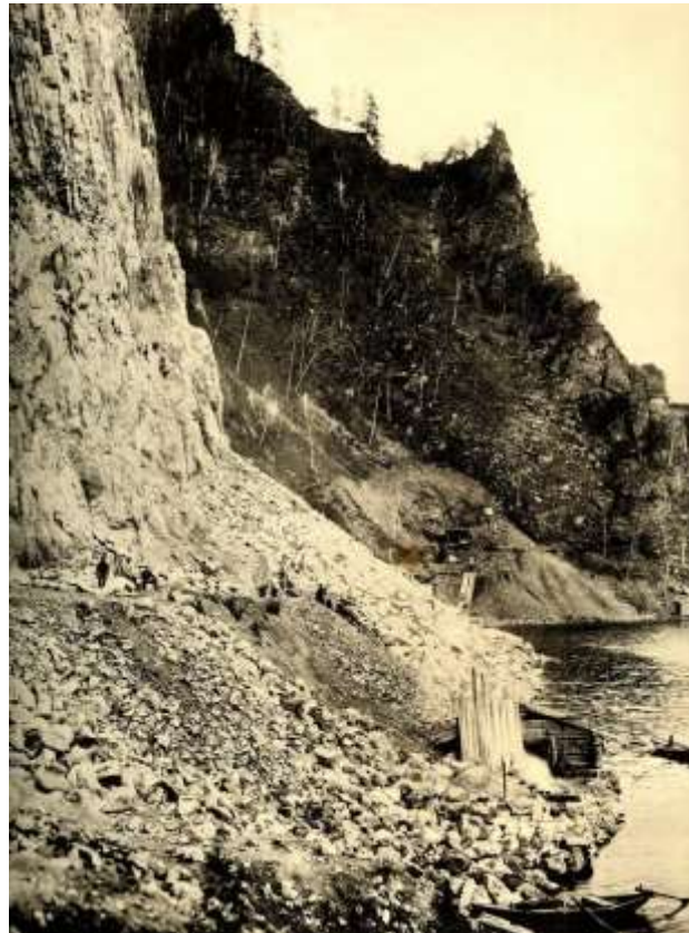
Рис. 2. Разработка выемки на утёсе Плоском, пик. 152-153, верста 57-я (131-й км), вход в тоннель № 26. 1903 г.
