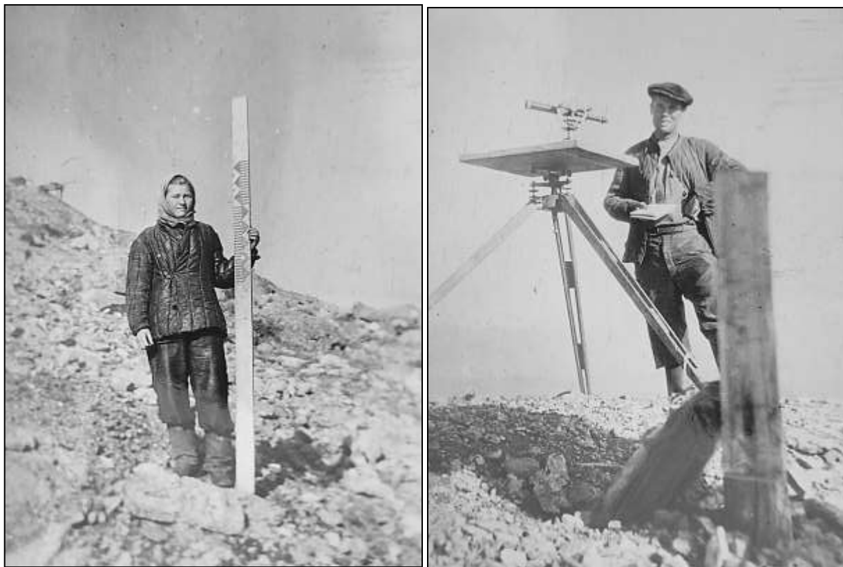
Рис. 15. Выполнение топографических работ. Справа — топограф Г.И. Столяров; слева — реечница Склянова. (Фото из отчета о геологоразведочных работах в 1950 г. (Глазов, 1951)).
