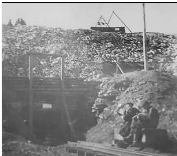
Рис. 9. Добывающая штольня возле Алиберовской шахты. (Фото из отчета о геологоразведочных экспедиции за 1942 год. (Флоренсов и др., 1942)).
