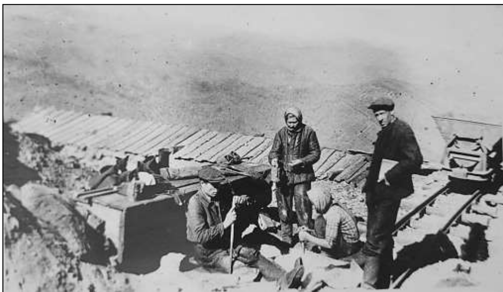
Рис. 17. Патронирование аммонита. (Фото из отчета о геологоразведочных работах в 1950 г. (Глазов, 1951)).
