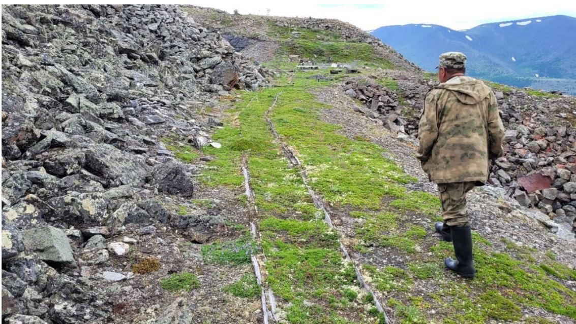
Рис. 22. Остатки рельсовой (деревянной) вагонеточной дороги. Фото 2021 г.
