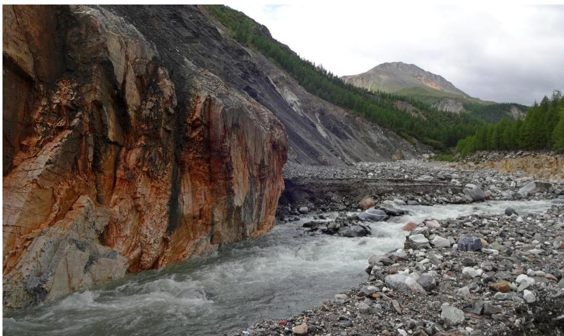
Рис. 11. Прижим выше осыпи. Дальше от прижима виден уровень выровненной площадки, до которого поднималась вода после перекрытия русла селевыми отложениями. Вода выше осыпи прозрачная. Фото А. Китова 08226 от 24.07.2024.
