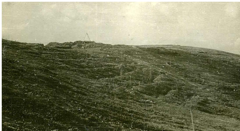
Рис. 2. Разведочные канавы на восточном склоне гольца (восточнее шахты Ж-П. Алибера (фото из отчета Ботогольской геологоразведочной экспедиции треста «Сибгеолнеруд» (Флоренсов и др., 1942)).
