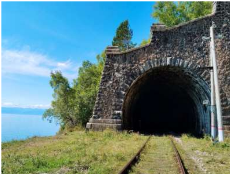
Рис. 8. Портал галереи, сложенный из тесаных каменных блоков и нетесаных глыб (циклопическая кладка). Фото автора, 2025 г.
