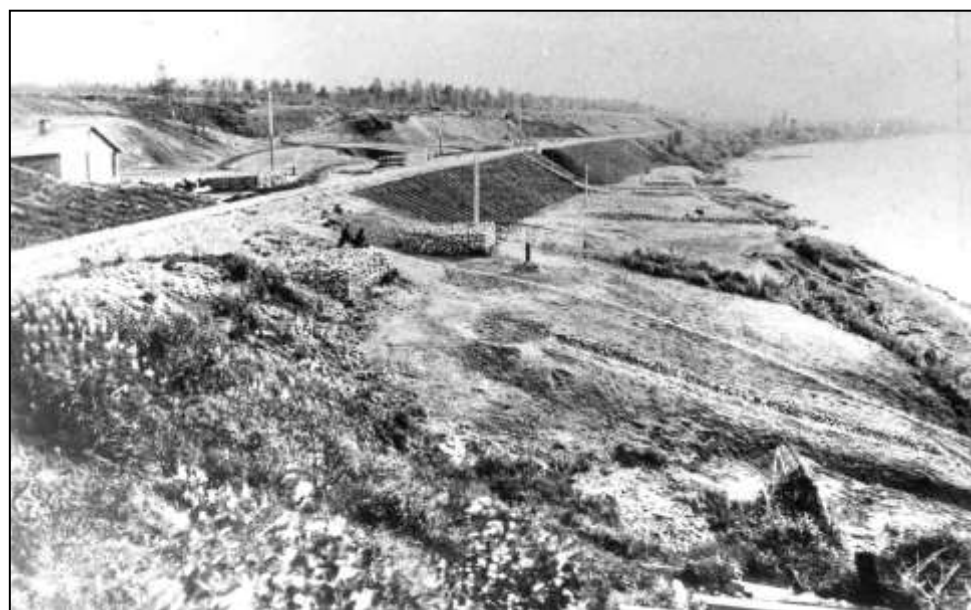
Рис. 3. Панорамный вид строительных работ вблизи ст. Мысовая (19 июня 1903 г.). Для предохранения дороги от волн Байкала берег укреплен камнями в плетневых клетках и каменными отсыпками в виде волнорезов (История..., 2003).
