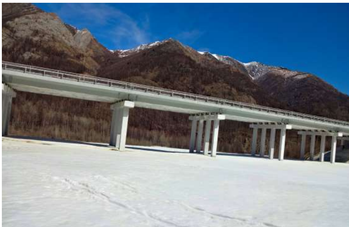
Рис. 27. Наледь Усть-Буговекская под автомобильным мостом. Вид вниз по течению, 02.05.2026, фото K1039
