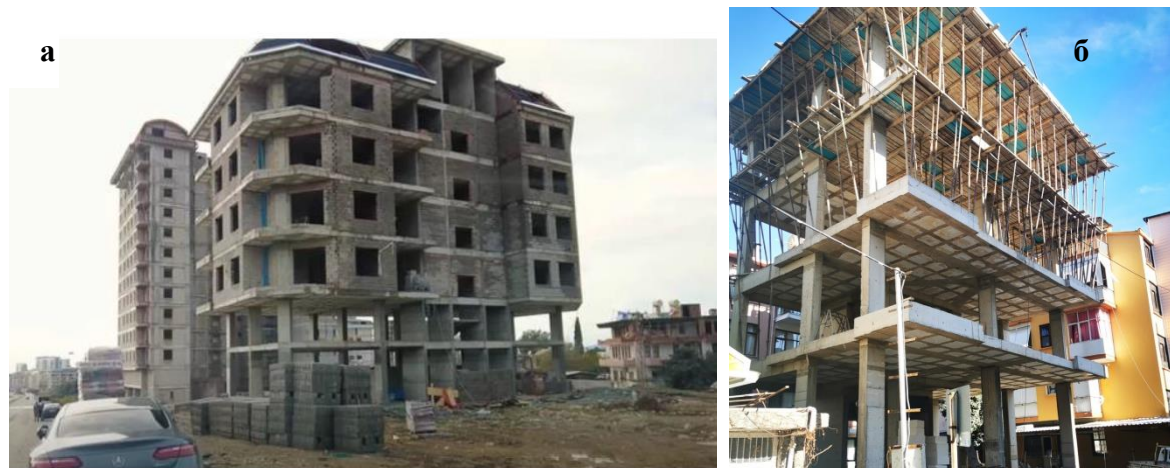
Рис. 3. Строительство многоэтажного здания по турецкой технологии. а – возведение монолитного каркасного здания с двумя нижними «гибкими» этажами (Акбиев, Абаканов, 2023); б – междуэтажное перекрытие с применением пенопласта (Строительство..., 2023).
